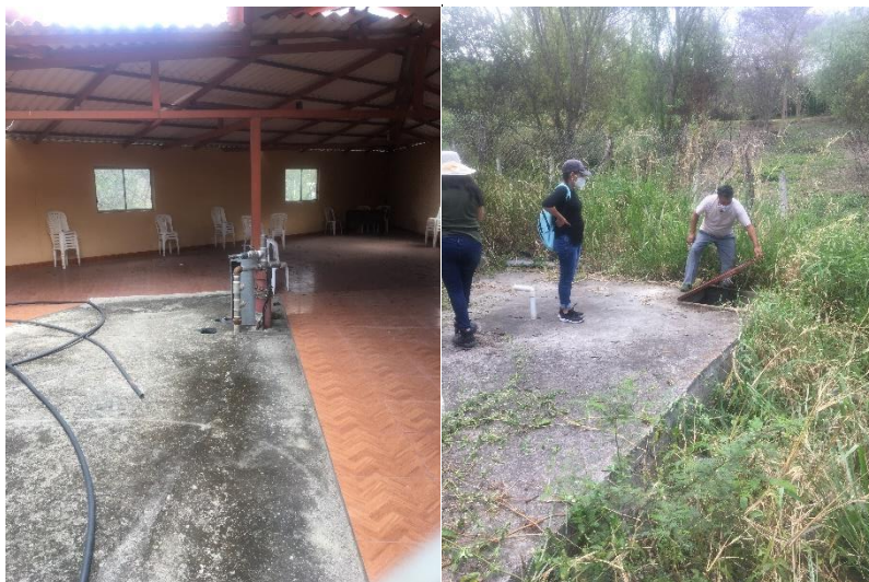
Fotografía 2.6.1.10.1.18 Bomba de Agua subterránea, tanque de agua Atalaya
