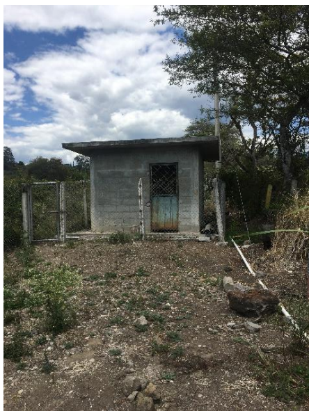
Fotografía 2.6.1.10.1.16: Captación de San Antonio
