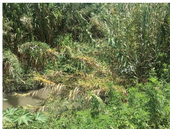
Fotografía 2.6.1.10.2.2: Laguna 2 de tratamiento en mal estado
