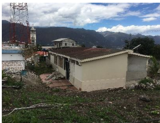
Fotografía 2.5.6.5.2: Centro de Salud en construcción.
