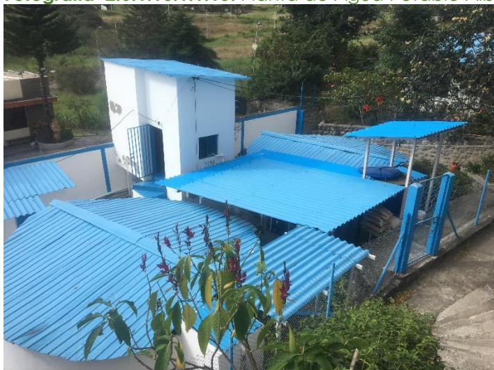
Fotografía 2.6.1.10.1.15: Planta de Agua Potable Albarroja
