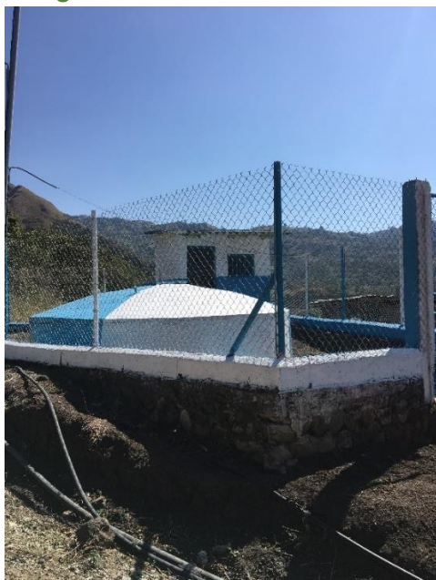
Fotografía 2.6.1.10.1.1.8: Planta de tratamiento y distribución la Unión
