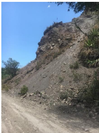
Fotografía 2.3.8.4: Deslizamiento vía a los tanques de agua residuales comunidad Portovelo Grande.
