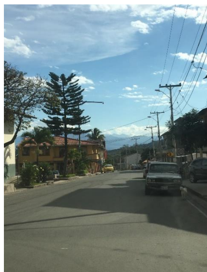
Fotografía 2.6.2.1.2.2.6: Señalización horizontal, no existen líneas de borde.
